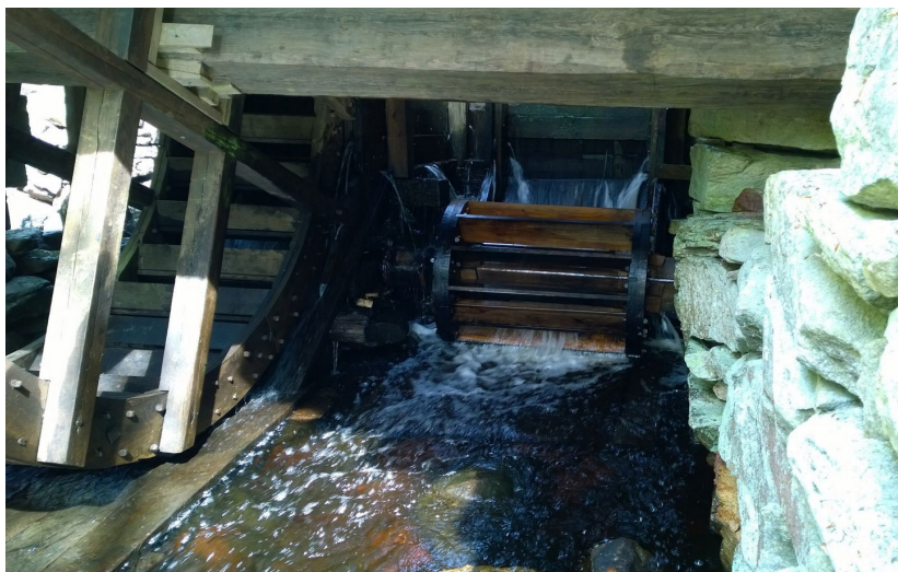
Sågkvarn: det mindre vattenhjulet driver sågen eller spånhyveln som gör takspån. (Bild från byggnadsminnet Brunnbacka sågkvarn i Halland, Wikipedia)
