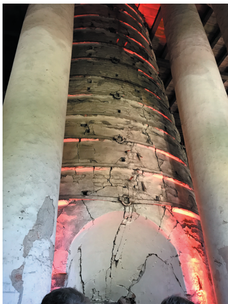
Masugns pipan har en diameter på 6 m, en väggjocklek på 2 m och en höjd på 13 m
