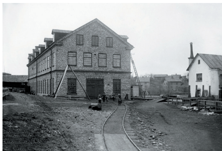
Holmens A-verkstads södra fasad. Vy mot norr med Brogatans bebyggelse i fonden. Foto Georg Nyström
