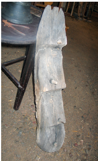
Det meterlånga spantet där "borden" varit fästa, troligen i aktern.
