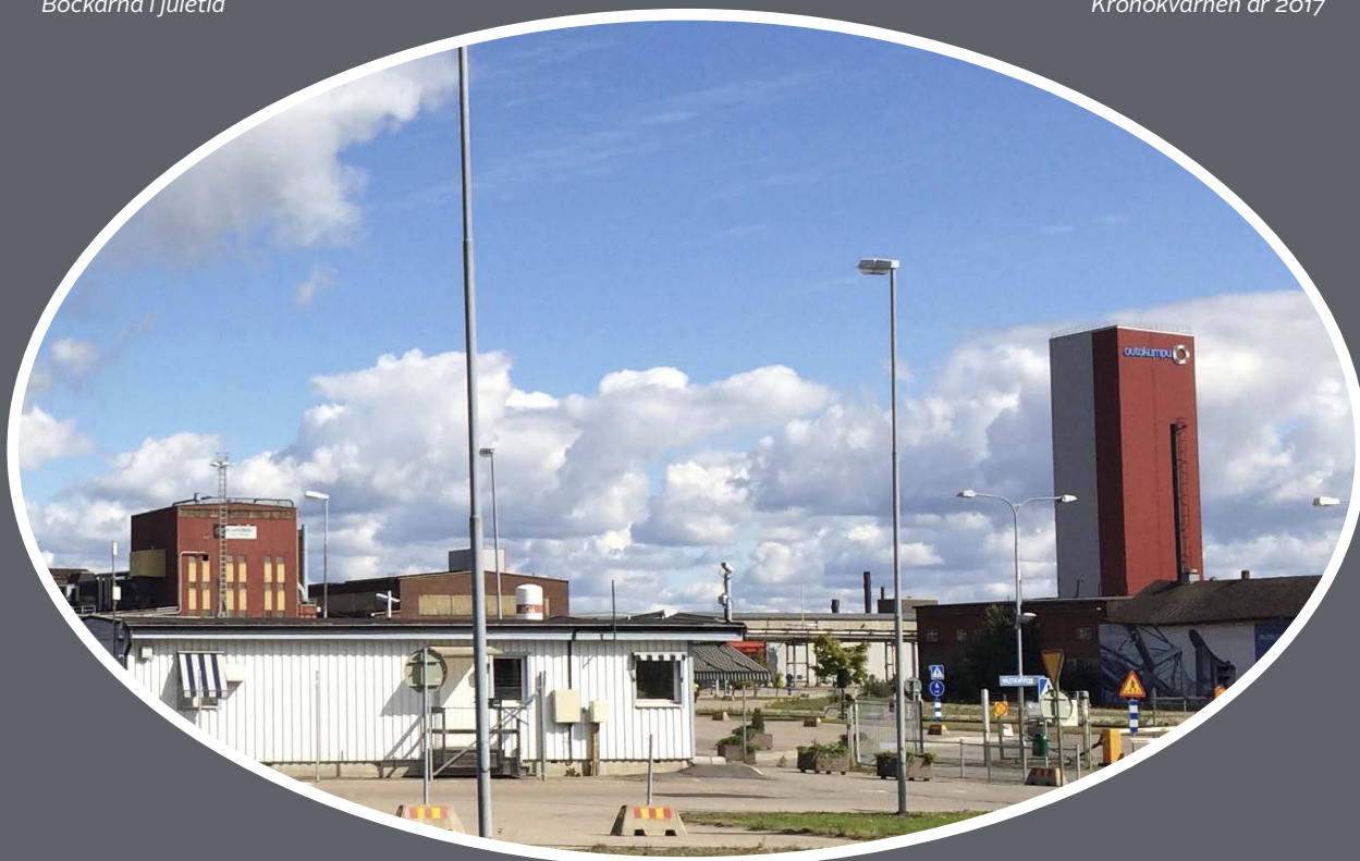
Nyby Bruk år 2017 med det 30 m höga Pulvertornet och kallvalsverkets 55 m höga Slingmagasinstorn i fonden bakom huvudporten
