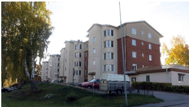
Det renoverade och tillbyggda Ringvägen 7
