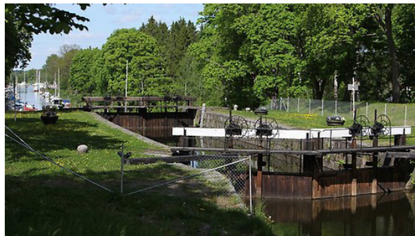
De gamla Slussportarna som ska bytas ut
