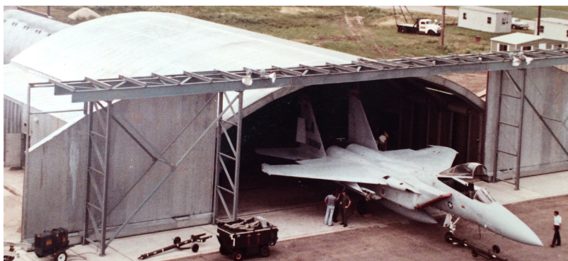
"Hyschhus" för att bekämpa bullret vid testkörning av främst jaktflygens motorer. Bilden är tagen i USA i samband med en stor exportorder till USA:s flygvapen
